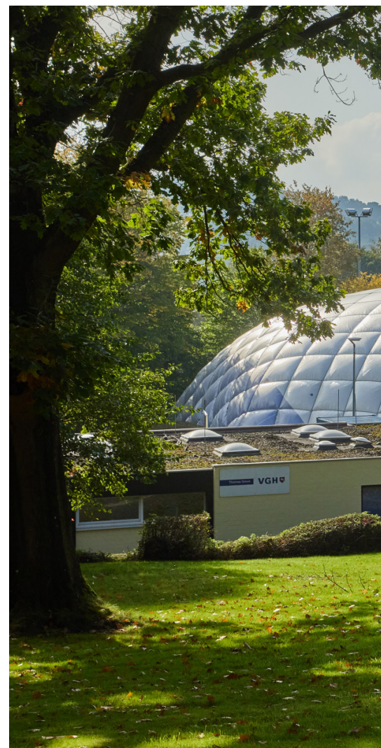
Mithilfe einer Traglufthalle wird das Waldbad Sünteltal im Wi
